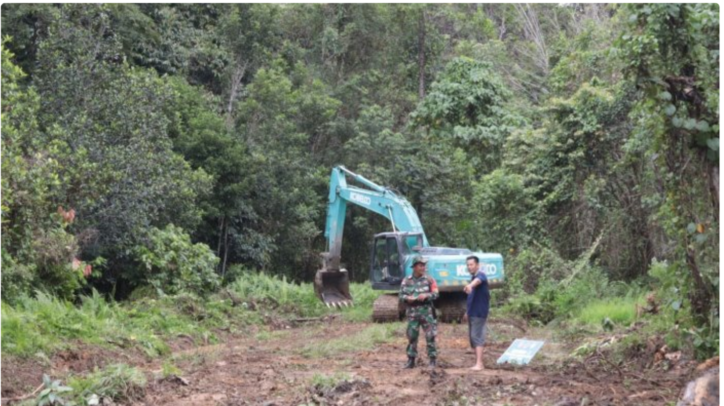
Wujudkan Aspirasi Warga, TMMD Wiltas 118 Kodim 0910/ Malinau Bangun Jalan Baru
