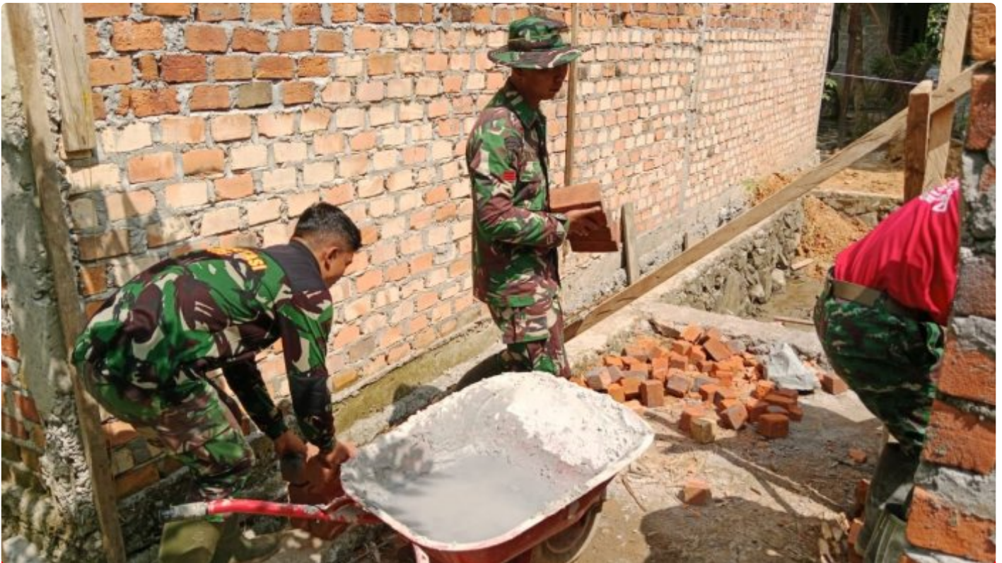
Satgas TMMMD Ke- 118 Wiltas Kodim 0910/Malinau Terus Kebut Pembangunan MCK Gereja
