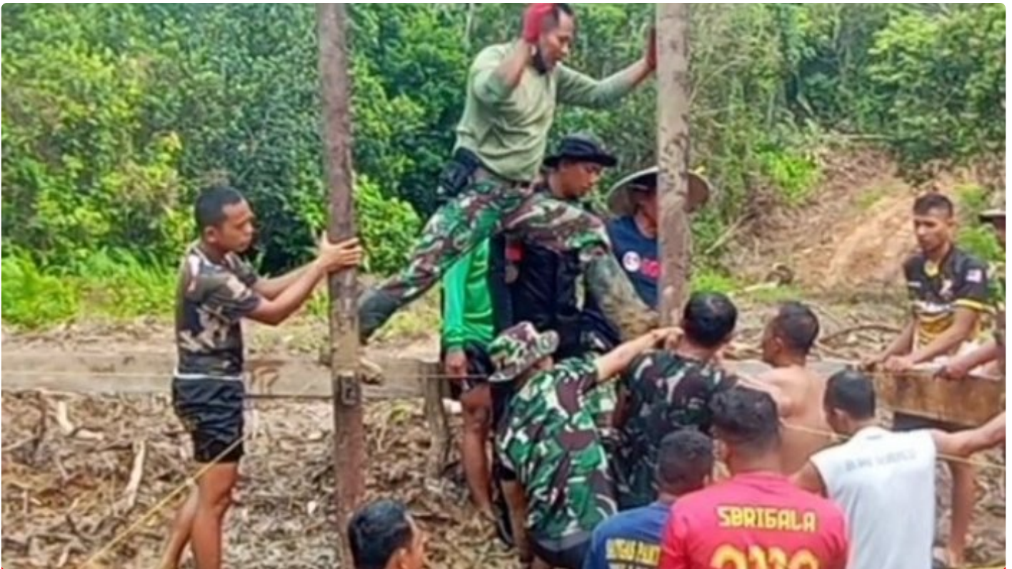
Satgas TMMMD ke- 118 Wiltas Kodim 0910/Malinau Pasang Tiang Pancang Jembatan
