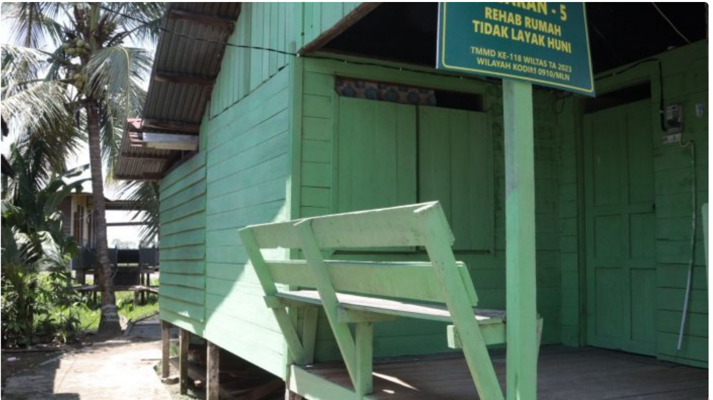
Sasaran Fisik Rehab RTLH TMMD Ke-118 Wiltas Kodim 0910/Malinau Selesai 100 Persen
