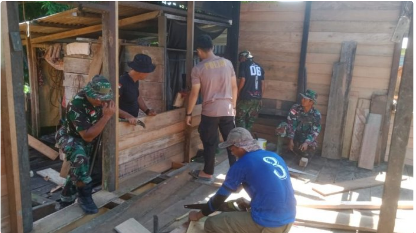
Rehab Rumah Warga, Satgas TMMD Ke- 118 Kodim 0910/Malinau Selalu Mengedepankan Kualitas
