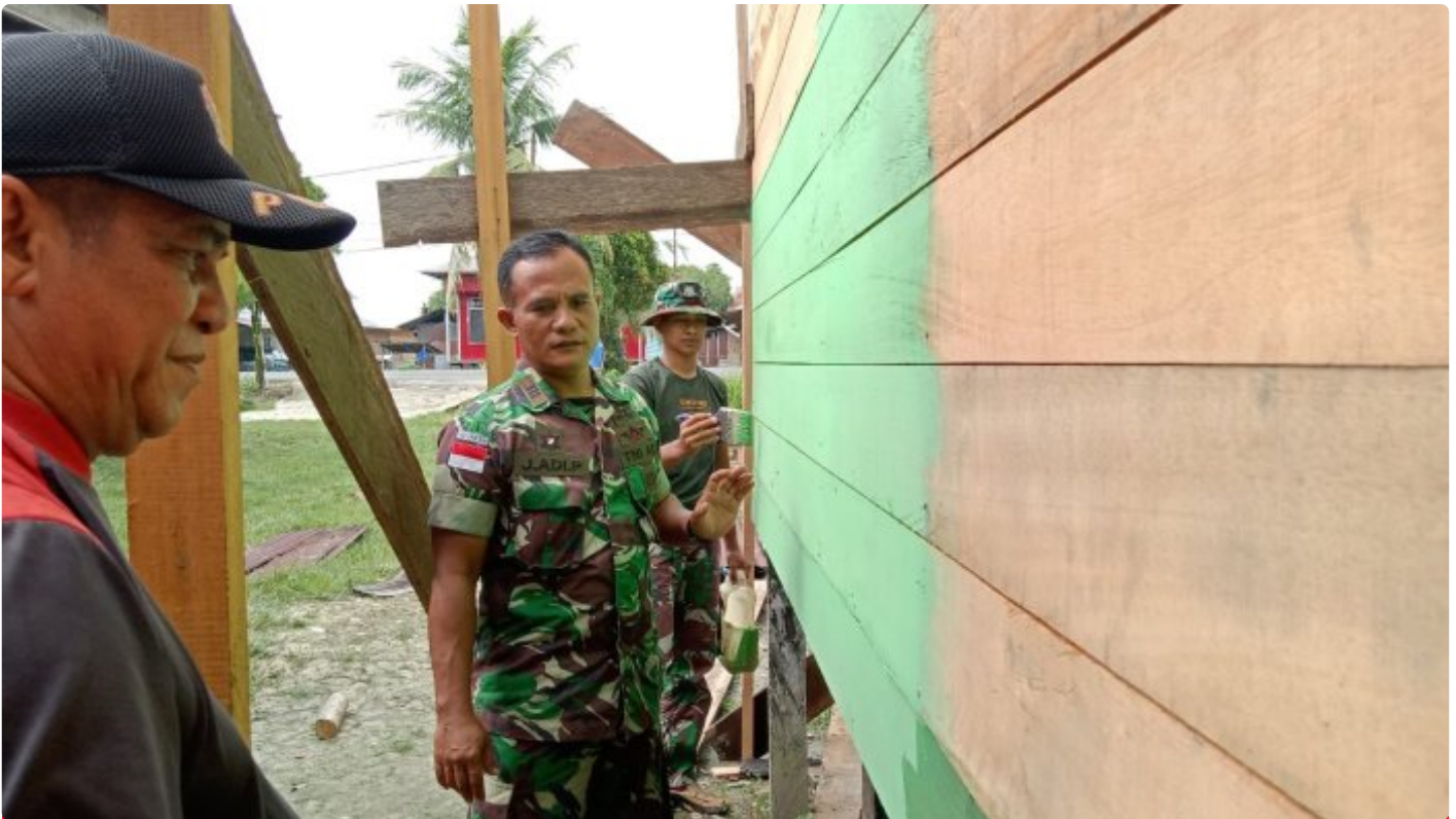
Pawas TMMD Ke- 118 Wiltas Kodim 0910/Malinau Cek Kualitas Rehab Tidak layak Huni
