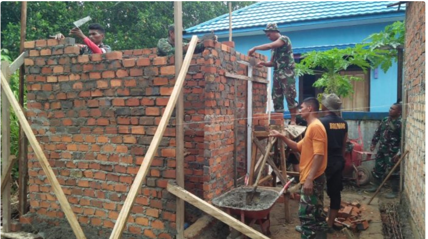
Pasiter Tinjau Proses Pekerjaan Sasaran Tambah TMMD ke-118 Pembangunan MCK Gereja
