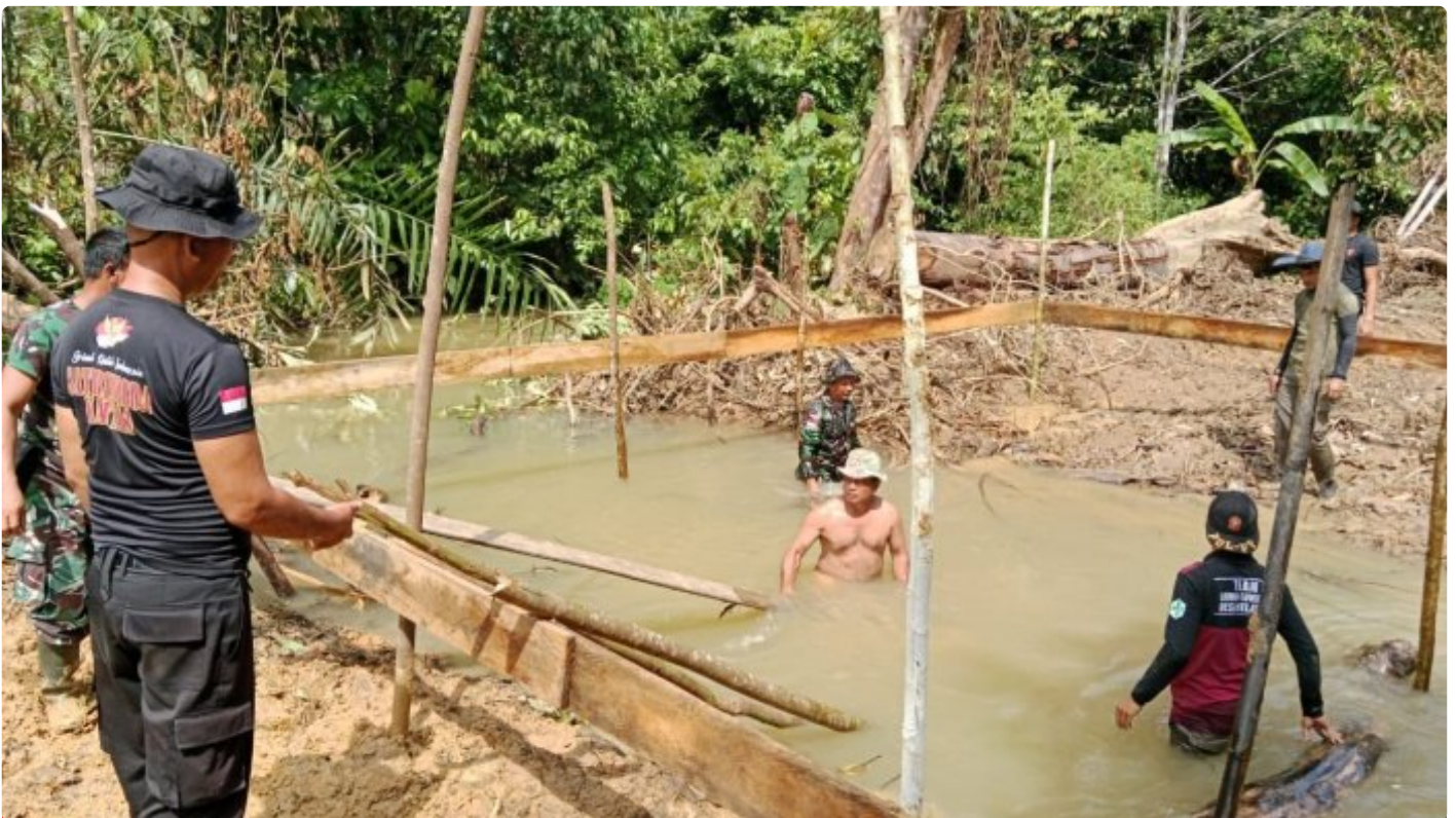
Jebur ke Sungai, Satgas TMMD ke 118 Kodim 0910/Malinau Pasang Papan Mal Jembatan
